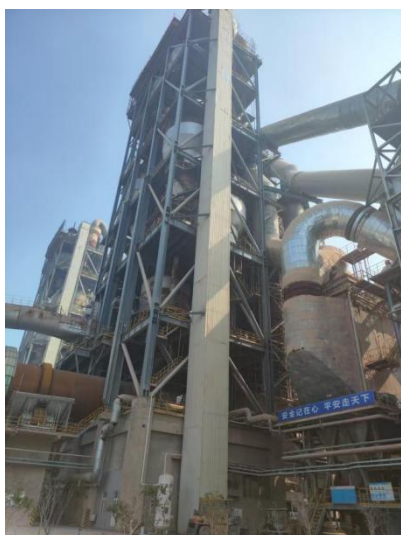
低氮燃烧+高温焚烧+碱性环境+SNCR 脱硝
