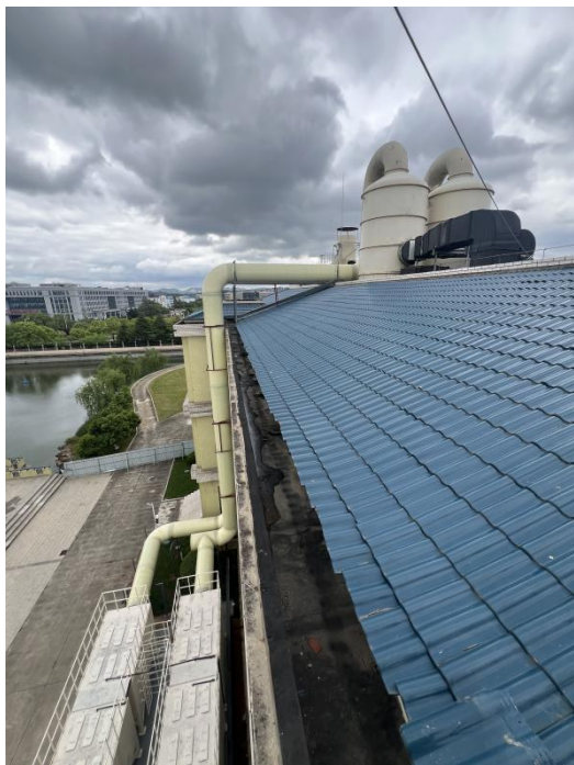
研发 2 号楼水喷淋+二级活性炭吸附装置
