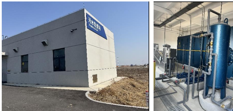
图 3-6 污水处理站照片
