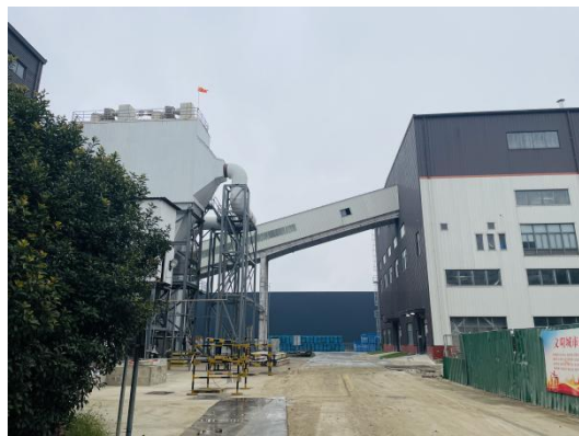
配料输送天桥及碎玻璃系统
