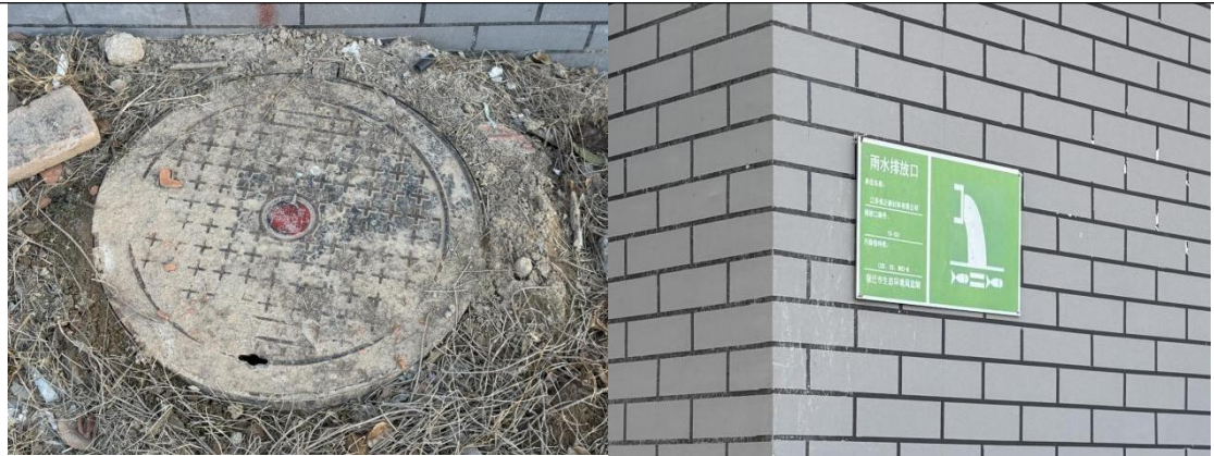
图 6 雨水排口现状照片
