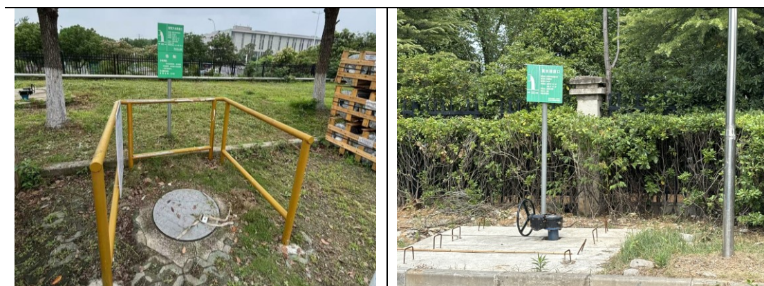
图 3-4 厂区雨污排口现场照片
