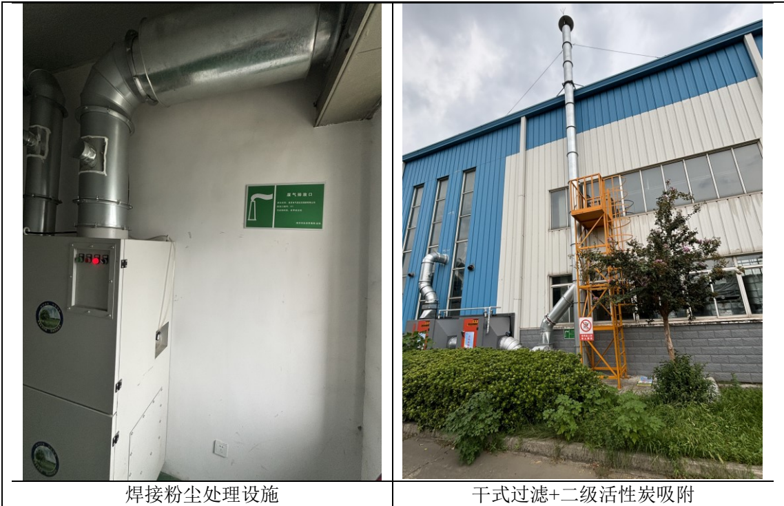
图 3-3 废气处理设施现场照片
