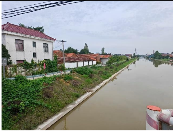
混凝土桩板式护岸及栏杆
