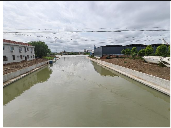
桩板护岸+联锁块护坡
