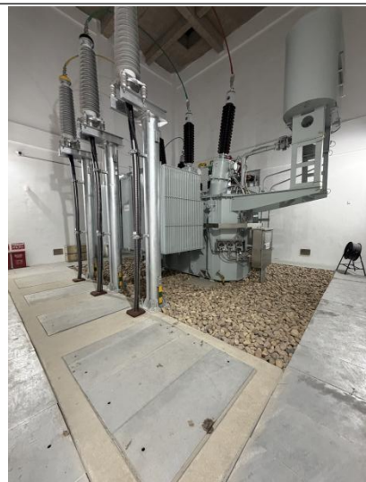
图 4-2 本工程变电站#2 主变及铭牌照片
