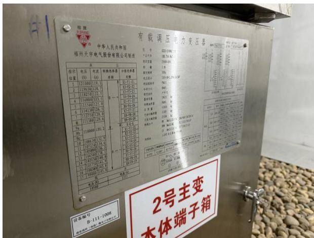
图 4-2 本工程变电站#2 主变及铭牌照片
