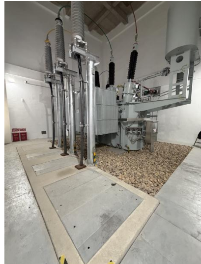
图 4-1 本工程变电站#1 主变及铭牌照片
