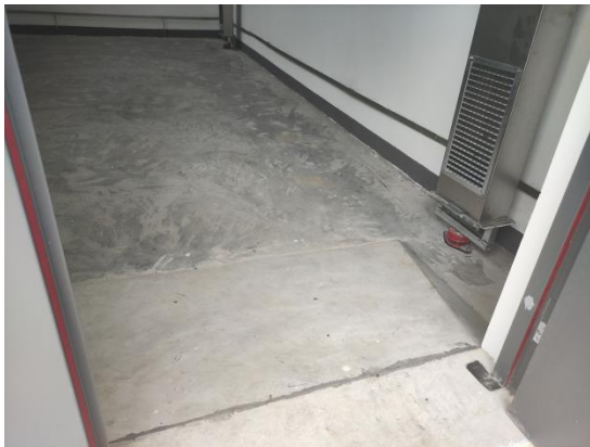
危废贮存地面重点防渗
