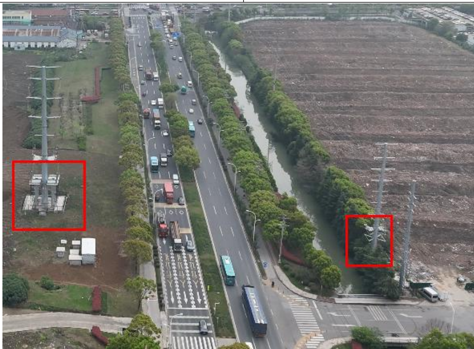
新建塔基处生态恢复
