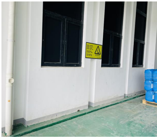
危废仓库地面防渗
