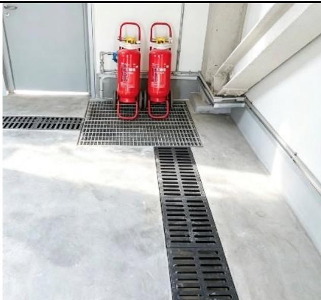
危废库、化学品库内部导流沟、收集坑、防渗措施、视频监控照片
