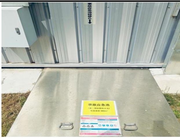
事故池（兼作二期区域初期雨水池）照片
