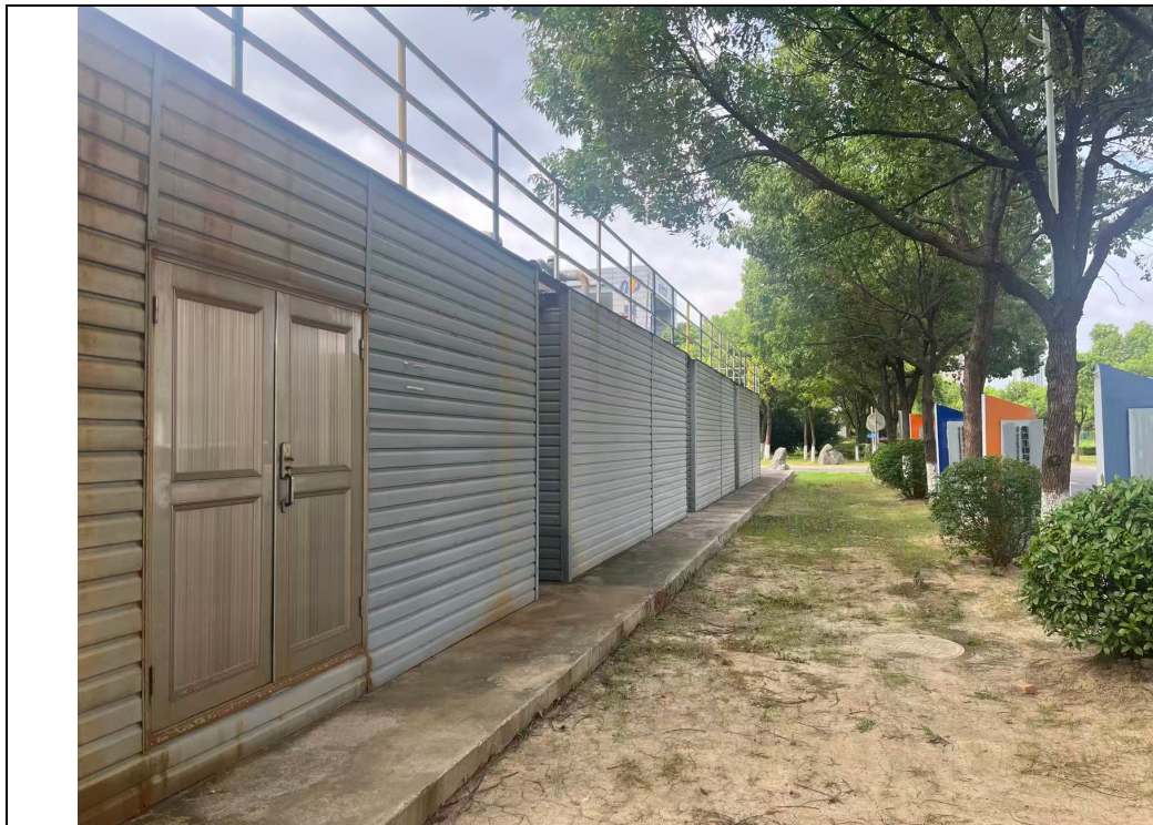
厂区污水站现场照片
