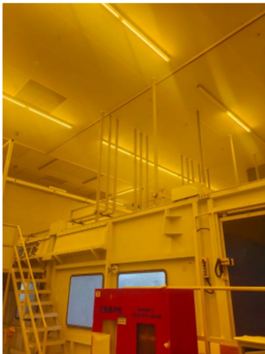
薄化密闭设备及废气收集管道
