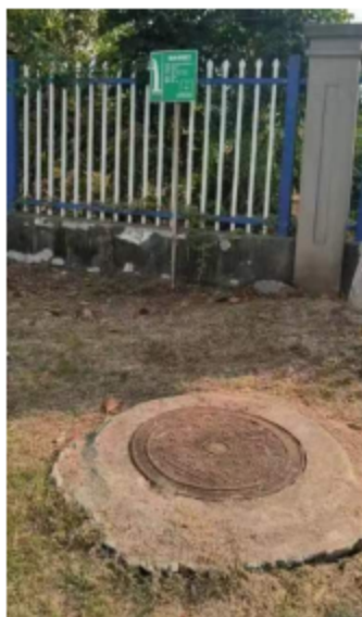
雨水排口标志标识
