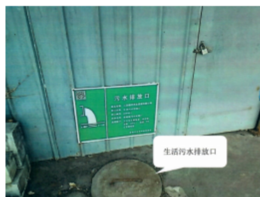
污水排口标志标识
