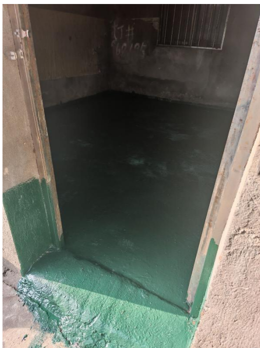
图 3.1-4 危废仓库标识牌、防渗措施
