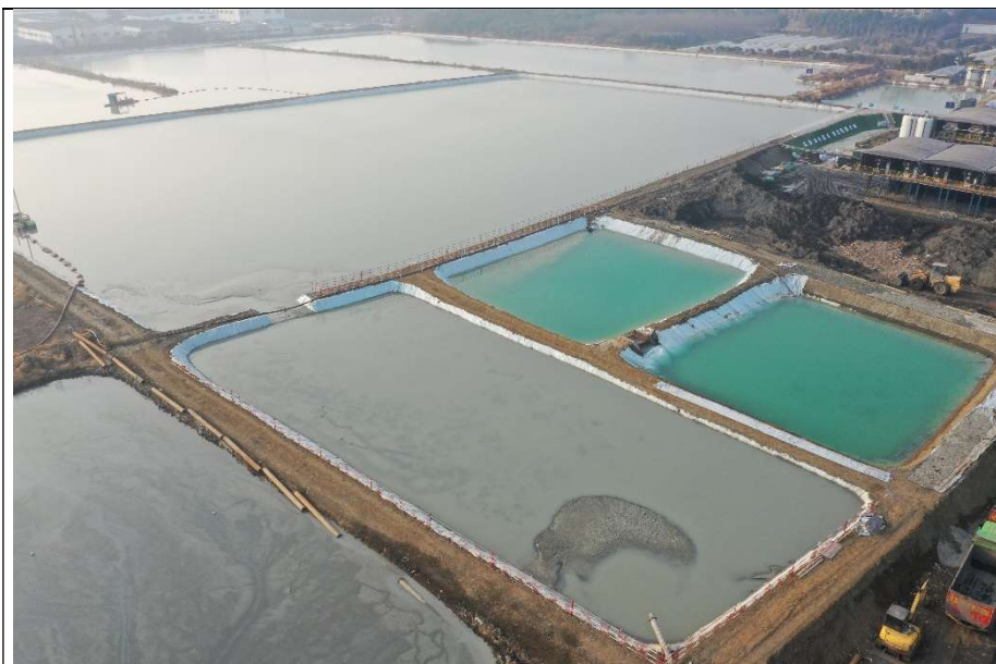
北片区余水处理池
